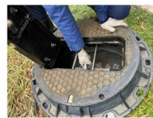
ゲート蓋の内部 (取っ手を引き上げ排水)
