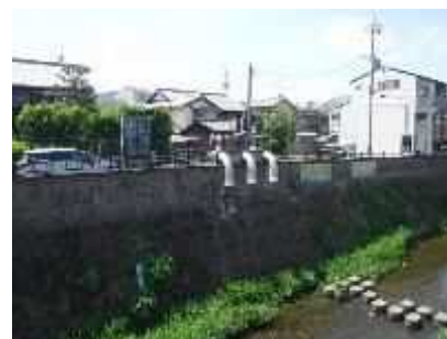
③排水機場の整備（構口排水機場）
